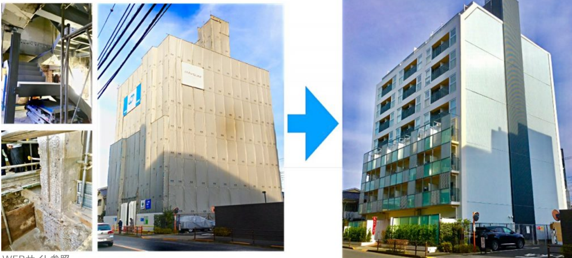
WEBサイト参照 https://www.raysum.co.jp/project/example03/
