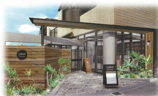
WeBase鎌倉の正面は湘南のそよ風を柔らかく取り込みます
