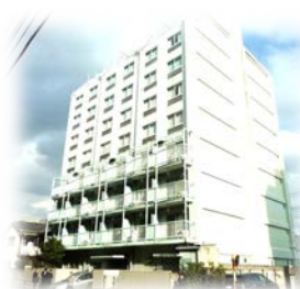
Before 老朽化した寄宿舎
