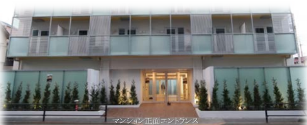
マンション正面エントランス
